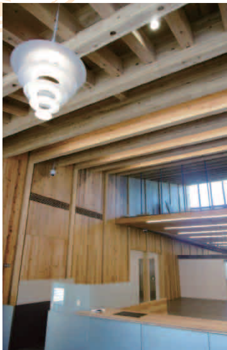
▲吹き抜けにしたことで2階からの陽射しを店内へ注ぎます。
