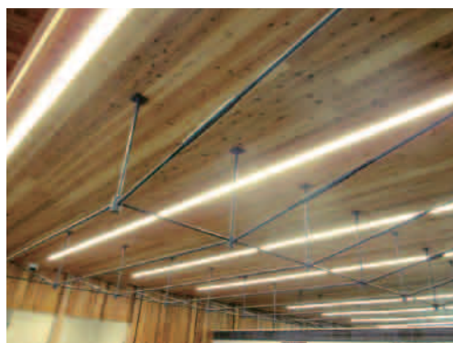
▲CLT床と鉄筋が一体となり構造体をなす“調弦梁構造”を採用。無柱空間を実現する大スパンを可能にしました。
